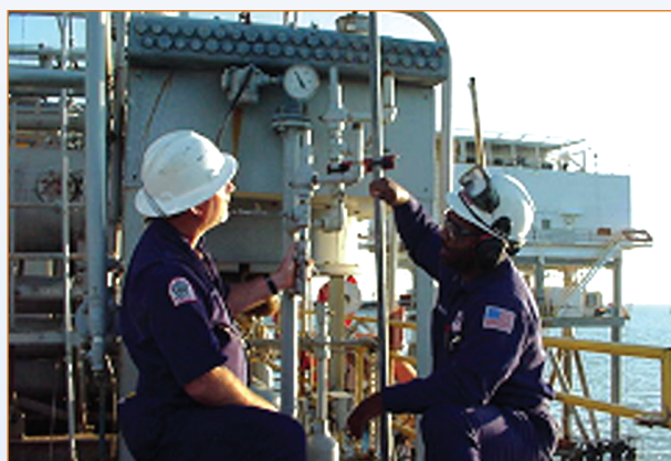
图表 2: 安装低渗漏（低排放）阀门是一种减少气体损失的高成本效益方法。
